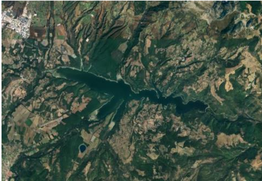
Fig. 2. Diga di Pertusillo
